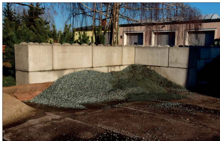
V areálu TSMJ se na shromažďování různého materiálu dobře osvědčil betonový tzv. LEGO systém. Přispívá k udržování pořádku, lze ho jednoduše přesunout na jiné místo a instalovat bez stavebního povolení
